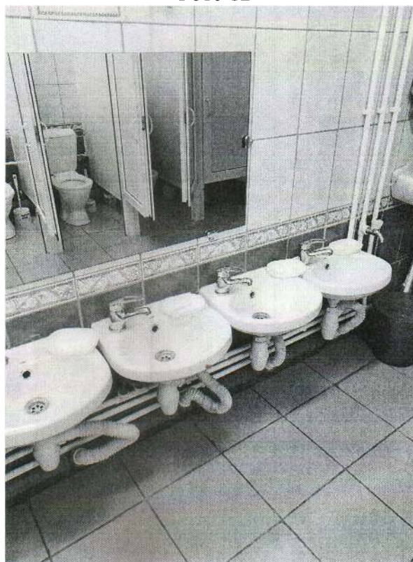
Санитарно-гигиенические помещения Фото 12
